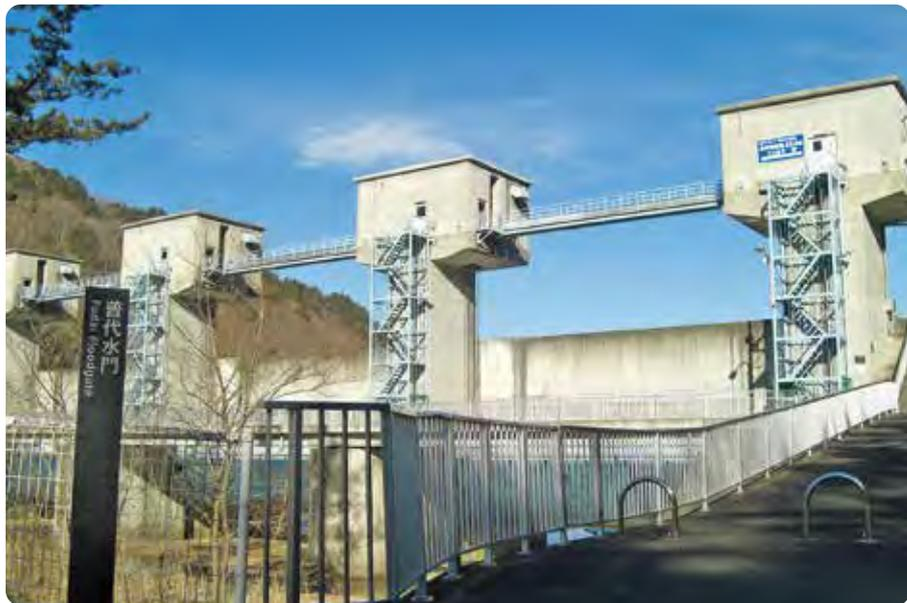
普代水門と太田名部防潮堤が住宅地や集落中心部への津波到達を防いだため、津波による死者・住宅被害はゼロとなった。その結果から普代水門は「奇跡の水門」ともよばれている
