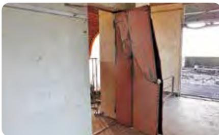
津波の衝撃でへし曲がった扉。津波は屋上に達する14.2mの高さで、外壁には津波高を示す看板もある。津波から少しでも早く遠くへ逃げる場合、どのタイミングで避難行動を開始するべきかを考えよう
