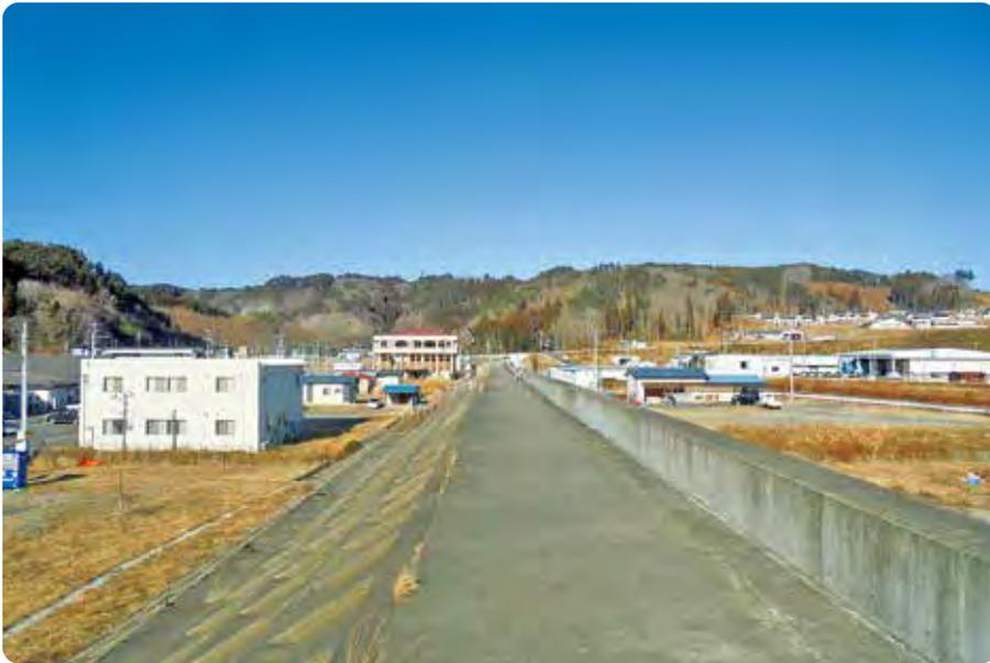
現在、壊滅を免れた第二線堤（旧第一防潮堤）は地盤沈下分をかさ上げして原形復旧され、津波の脅威を後世に伝えていきます。倒壊後に新たに整備された第二線堤とともに、ハード・ソフトの両面から、今後の災害時の防災が期待されています。
