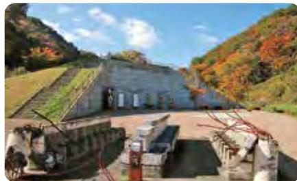
震災遺構として震災当時のまま保存されている「炊事棟」。直径40cmのコンクリート柱がへし折られ、鉄筋がねじ曲げられている。押し寄せた波ではなく引き波によって傾いており、引き波の威力を物語っている
