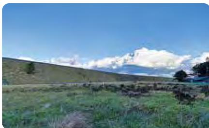
津波供養塔のある野原の向こうには高さ12mの川尻防潮堤が続く。防潮堤上部は遊歩道になっていて歩行者の通行が可能。遊歩道を進むと、津波の時に川からの逆流を堰き止める水門がある
