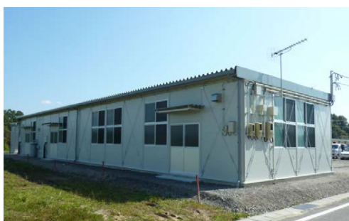
(福島市松川地区飯館仮設工場 (福島県福島市))
