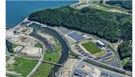
釜石鵜住居復興スタジアム(用地造成:岩手県釜石市)
