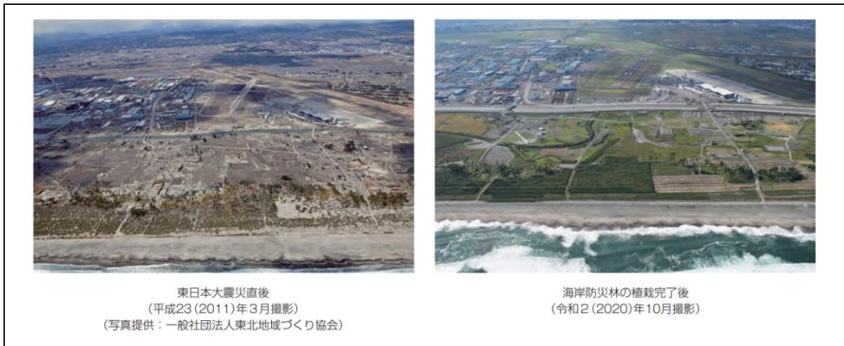
図表 5-12-5 被災直後と植栽後の仙台湾沿岸海岸防災林
