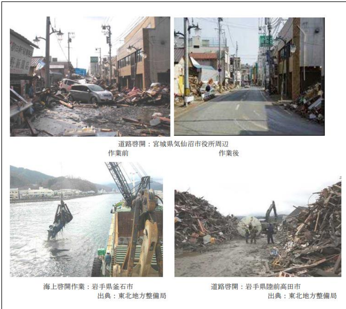
図表 5-14-7 道路啓開、海上啓開の状況
