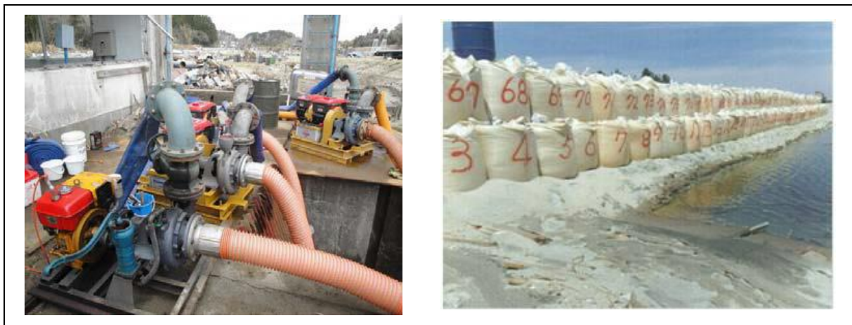
図表 5-11-3 排水ポンプ設置等の応急対応の実施（宮城県）
