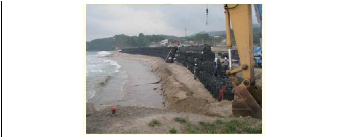
図表 5-12-2 大型土のうによる緊急対策工事
