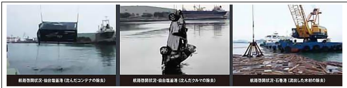
図表 5-10-2 仙台塩釜港における航路啓開作業の様子
