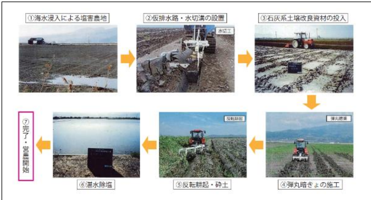
図表 5-11-10 除塩の作業手順例
