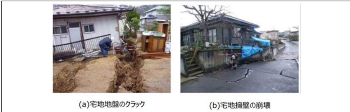
資料) 国土交通省「大規模盛土造成地の滑動崩落対策について 3. 過去の被害事例 (4) 2011年 東北地方太平洋沖地震の事例 (谷埋め型大規模盛土造成地)
