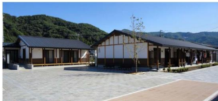
(集会所(左側)、住棟(右側)と広場)
