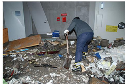
石巻文化センター 収蔵庫付近の状況 (2011年4月20日)
