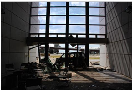
石巻文化センター 入口付近の状況 (2011年4月20日)
