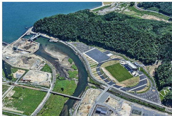
釜石鵜住居復興スタジアム (岩手県釜石市)
