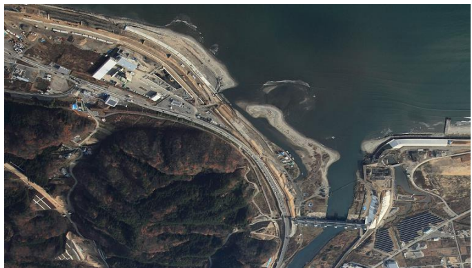
緊急使用箇所（工事中）
