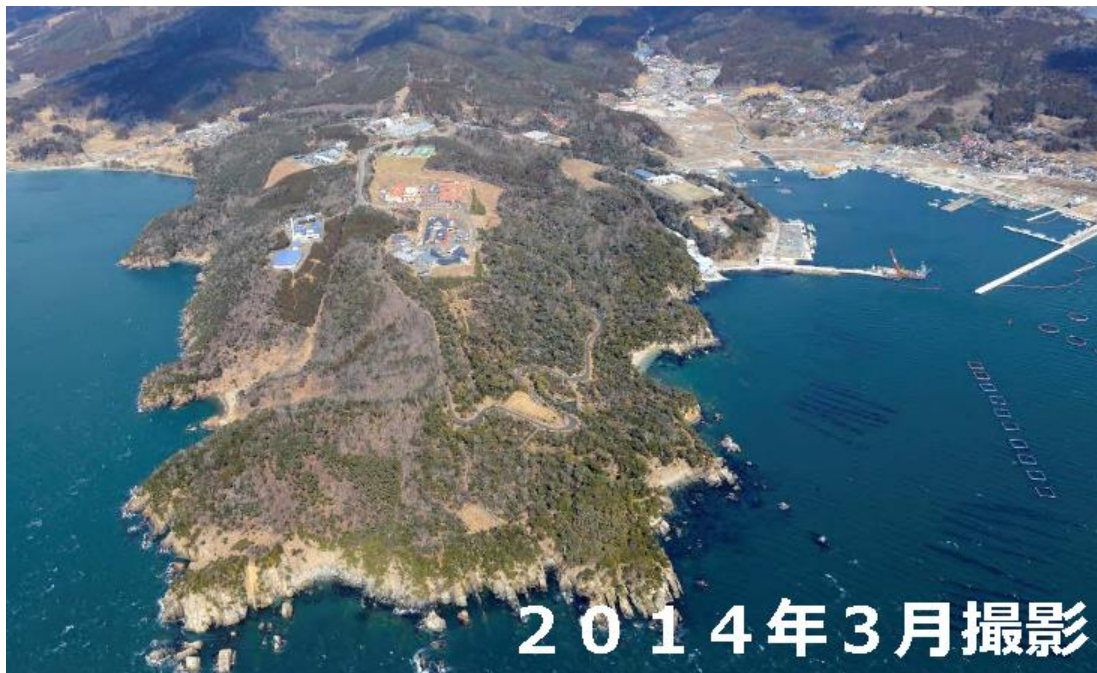
図表 2-3-31 石巻市鮎川浜地区
