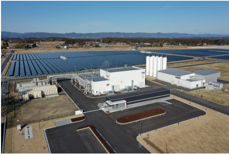
図 7-5-5 完成した福島水素エネルギー研究フィールド (FH2R)
