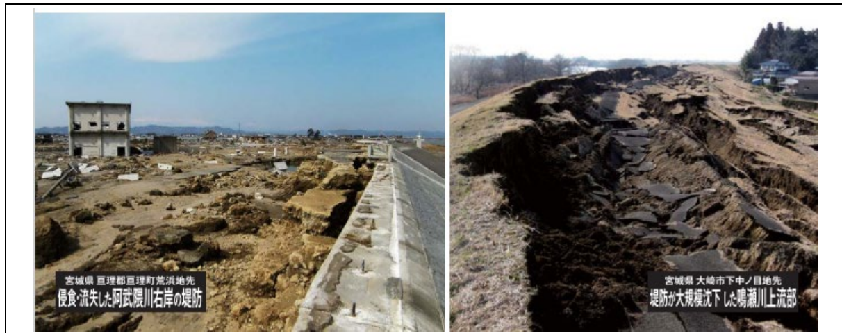
図表 5-6-4 河川堤防の損壊例
