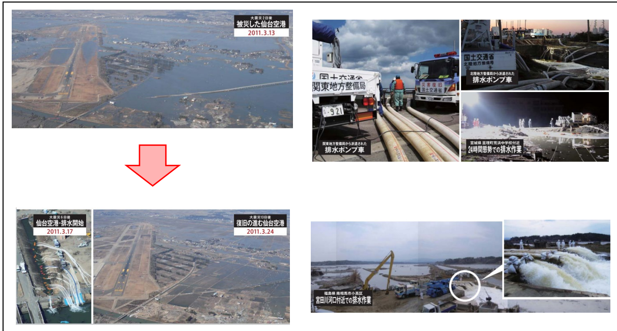
図表 5-6-6 排水ポンプ車の出動例
