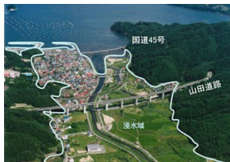
三陸沿岸道路(山田道路)
