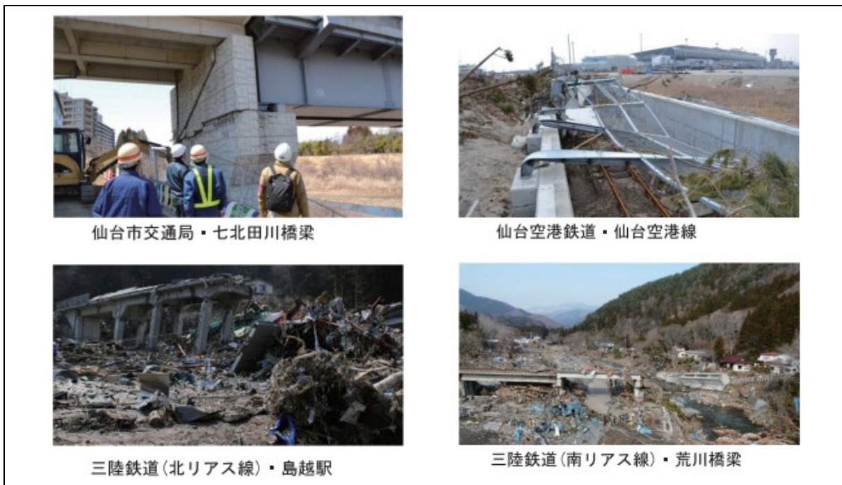
図表 5-8-2 地下鉄・第三セクター鉄道等被災状況
