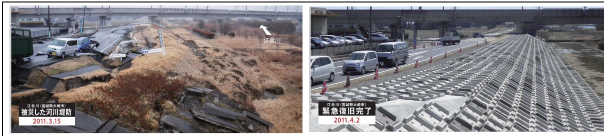
図表 5-6-7 河川堤防の緊急復旧工事例(江合川(宮城県大崎市))
