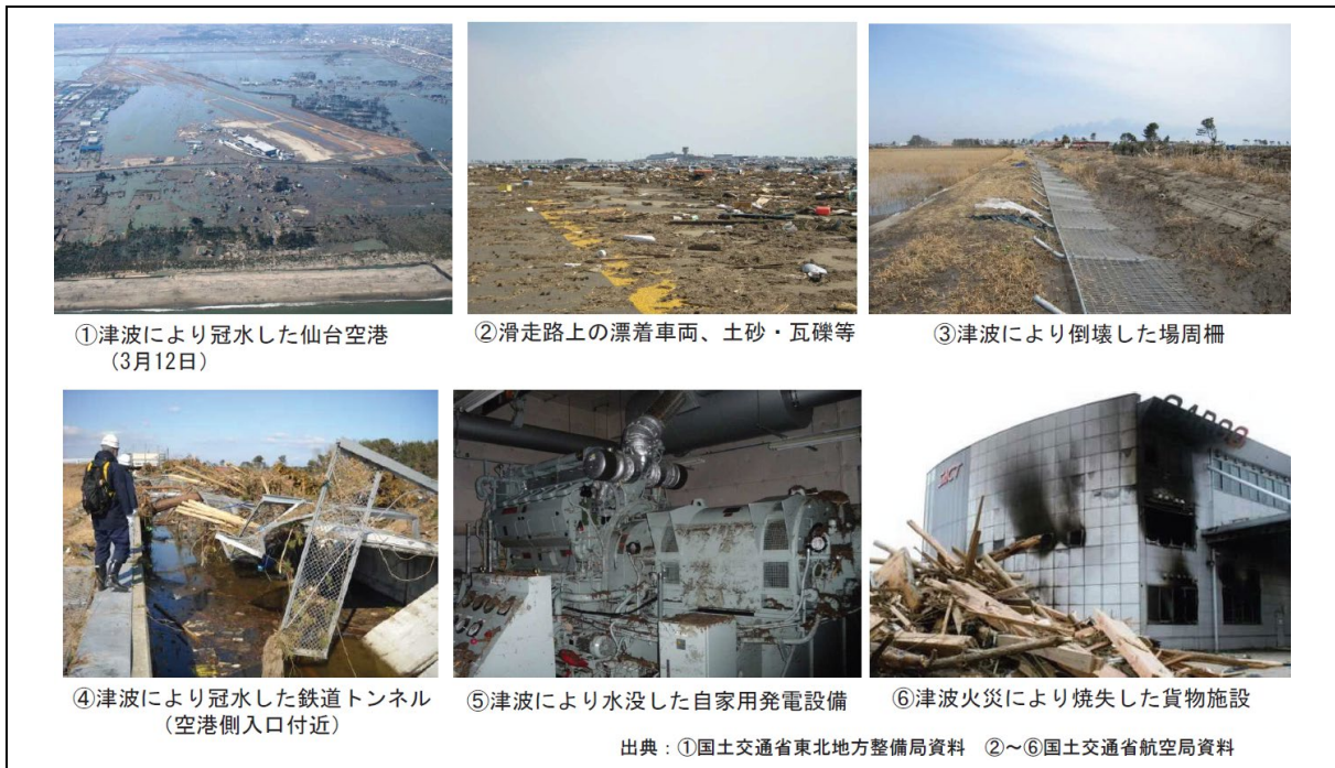
図表 5-7-2 仙台空港の被災状況
