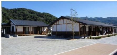
(集会所(左側)、住棟(右側)と広場)
