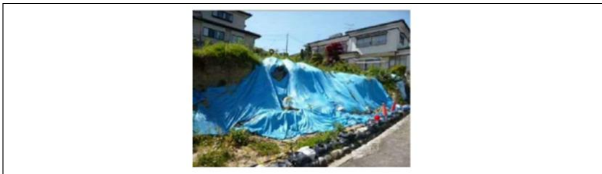
図表 5-4-4 ひな壇部分の変形被害が発生した地区の被害写真
