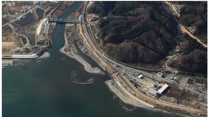
緊急使用箇所(工事中)
