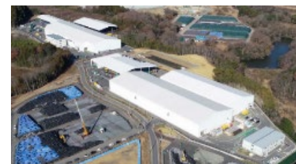
中間貯蔵施設の受入・分別施設 外観(大熊町)
