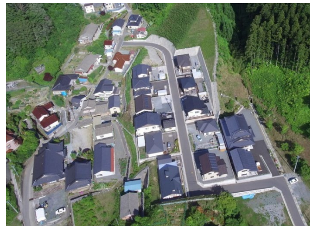
防災集団移転促進事業（大船渡市） （平成30年6月）
