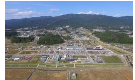
陸前高田市高田地区 (令和2年12月 宅地造成完成) 土地区画整理事業 (復興交付金) 活用
