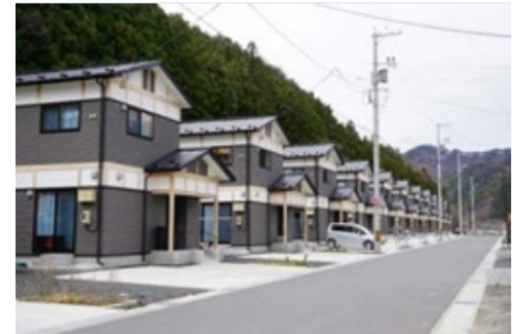
大槌町寺野 災害公営住宅 (平成27年9月完成) 復興交付金活用
