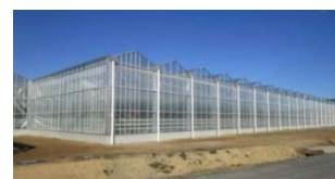
高軒高のガラス温室
