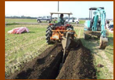
暗渠排水の設置
