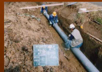
農業用水路の設置
