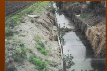
老朽水路の改修
