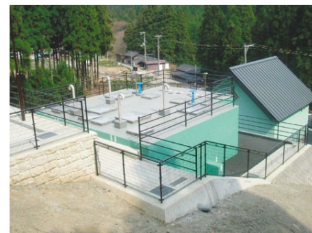
【簡易水道の整備】
