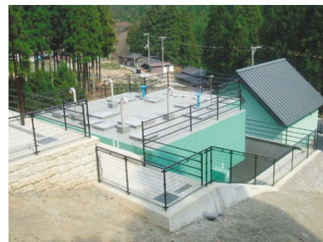
【簡易水道の整備】
