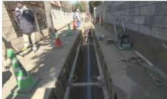
下水道管渠整備
