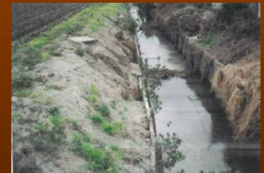
老朽水路の改修
