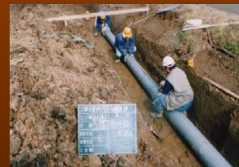
農業用水路の設置
