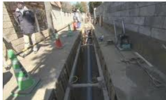
下水道管渠整備
