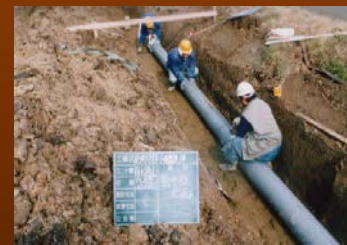
農業用水路の設置
