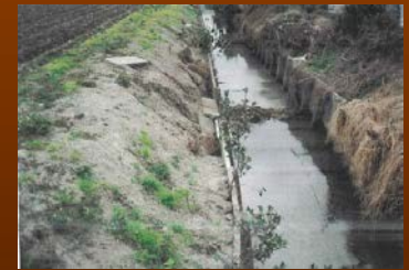
老朽水路の改修
