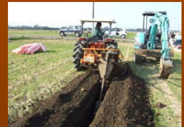
暗渠排水の設置
