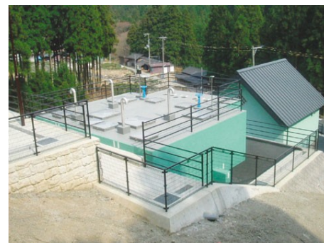
【簡易水道の整備】
