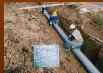
農業用水路の設置
