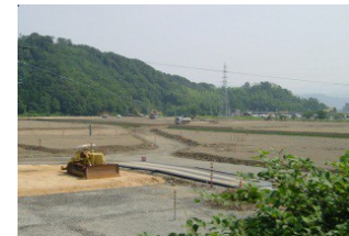
【工業団地造成の例】
