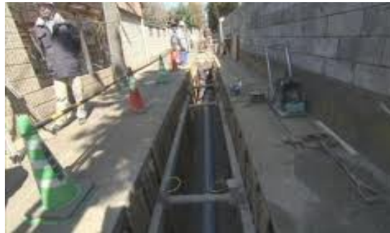
下水道管渠整備
