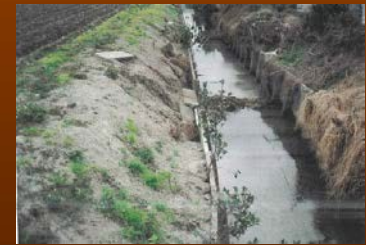
老朽水路の改修
