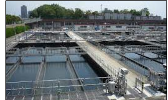
下水道処理場の整備
