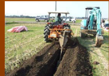
暗渠排水の設置
