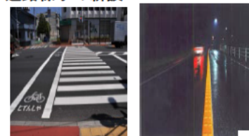
道路標示の新設
