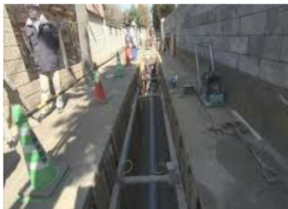
下水道管渠整備
