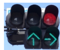
信号機改良(多現示化・LED化等)
