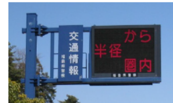
交通情報板の新設
