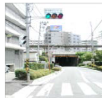
信号機の新設
