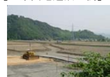
【工業団地造成の例】
