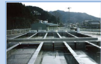
さけ・ます種苗生産施設
