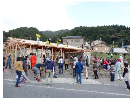
崎浜番屋「浜らいいん」建築の様子
