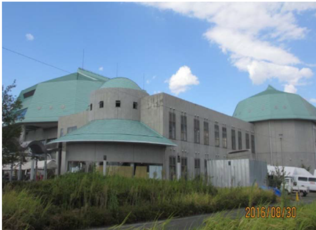
避難所となった益城町総合体育館
