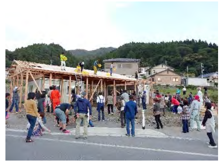
崎浜番屋「浜らいん」建築の様子
