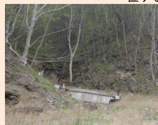
震災後：漁港上流域の宮古市重茂と奈地区は河口から500mまで津波が押し寄せ、森林面積約3haに被害。むき出しの林地に橋が乗り上がっている。
