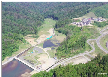
▲地盤沈下により湿地が出現
