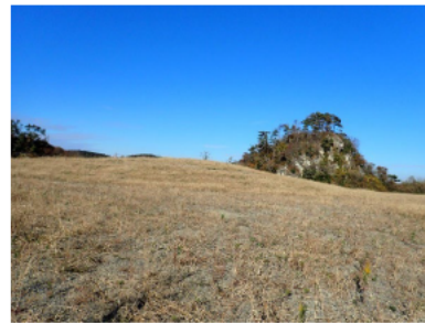
第Ⅰ期東側エリア (旧かんぼの宿跡：造成工事中)
