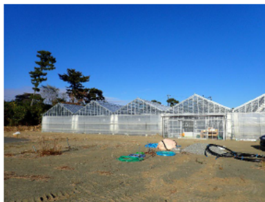
第Ⅰ期西側エリア (イチゴハウス：R5年2月オープン)
