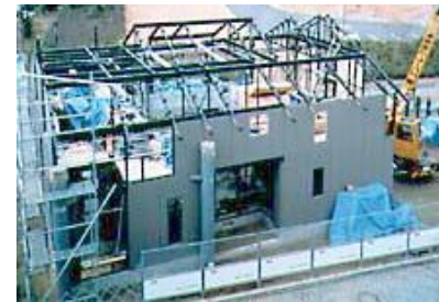
プレハブ(軽量鉄骨)工法
