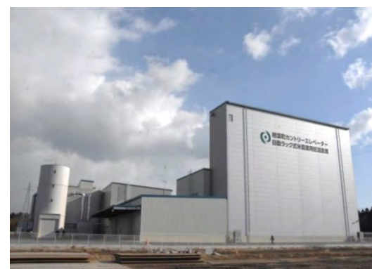
カントリーエレベーター
