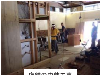
店舗の内装工事
