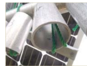
テストピース腐食状況
