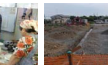
豊間仮設店舗工事着工
