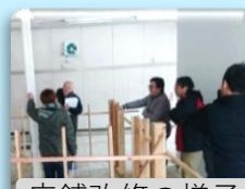
店舗改修の様子
