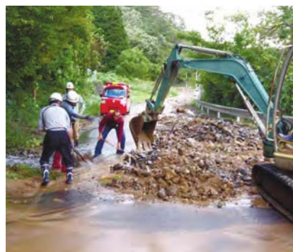
台風19号の被害に際し、住民自身で道路仮復旧にあたる様子。
