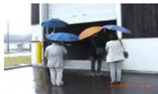
一の瀬木質チップ倉庫
