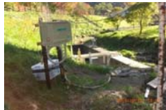
10月15日: 発電量を測定。そして修理したコントローラーを取り付ける。
