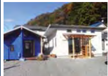
事務局運営施設
