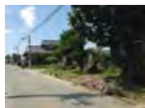
津波で被災した住宅街
