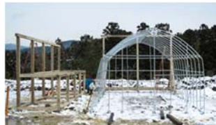
実証実験用施設の施工(施工中)
