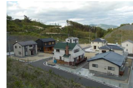
防災集団移転 (岩手県宮古市)
