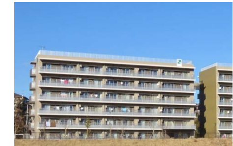
災害公営住宅 (宮城県石巻市)
