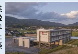
宿泊施設外観 （陸前高田市）
