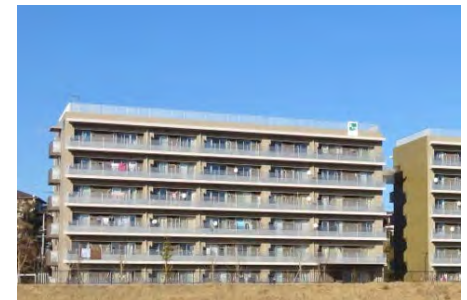
災害公営住宅 （宮城県石巻市）
