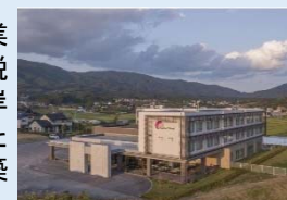
宿泊施設外観 （陸前高田市）
