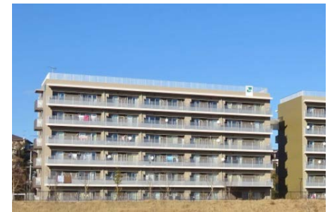
災害公営住宅 （宮城県石巻市）
