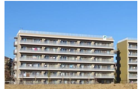
災害公営住宅 （宮城県石巻市）
