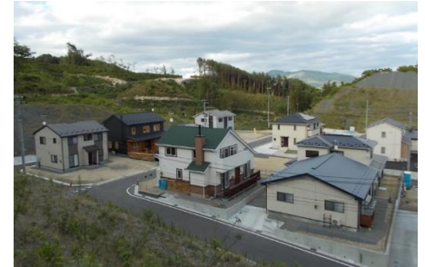
高台移転 （岩手県宮古市）
