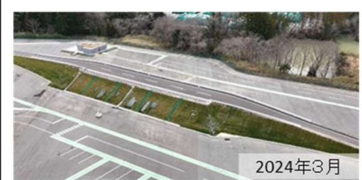
大熊町中間貯蔵施設内での道路盛土実証事業
