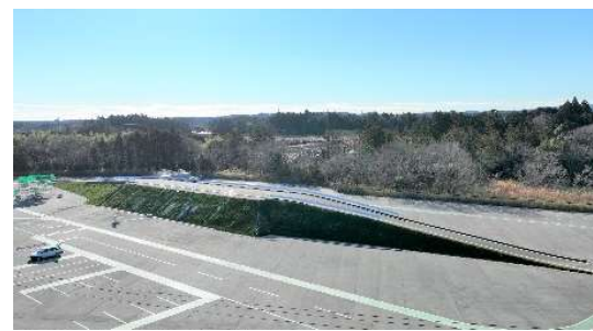
大熊町中間貯蔵施設内での道路盛土実証事業
