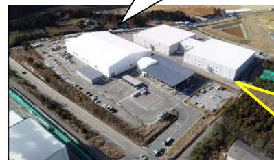
受入・分別施設 外観(大熊町)
