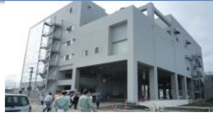
製氷・貯氷施設(宮城県気仙沼市) 平成24年3月交付決定。 平成24年10月中旬から稼働開始。
