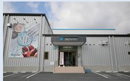
水産加工場外観 （女川町）
