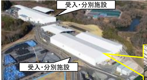
受入・分別施設 外観(大熊町)
