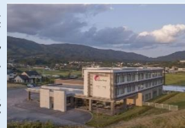
宿泊施設外観 (陸前高田市)
